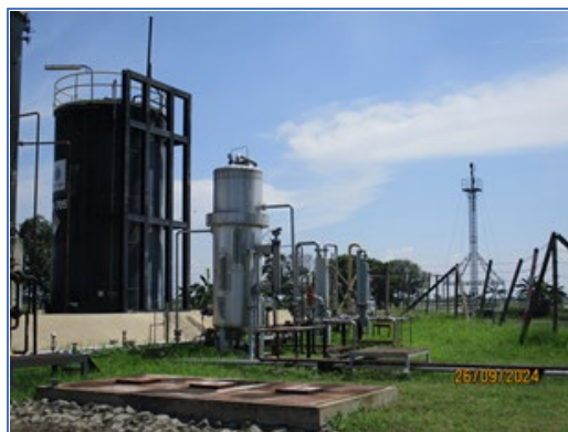
ภาพถ่ายที่ 2-32 เครื่องดักอนุภาคไฮโดรคาร์บอน (Flare Knock out Drum) ของฐานหลุมผลิตสังขาย
